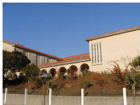
Fig. – Edifício dos Monfortinos
