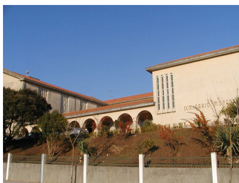
Fig. – Edifício dos Monfortinos
