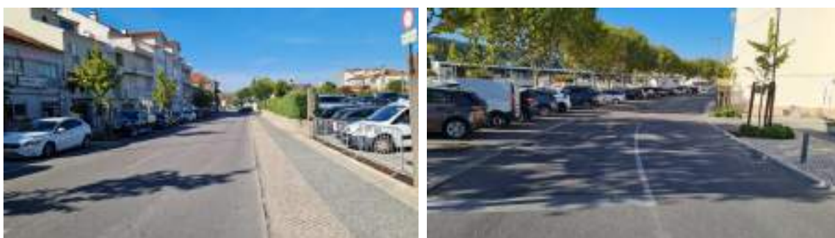
Figura 63. Rua Dr. Neves Eliseu (à esquerda) e Rua Dr. Francisco Sá Carneiro (à direita) (Fonte: levantamento de campo, 2025)
