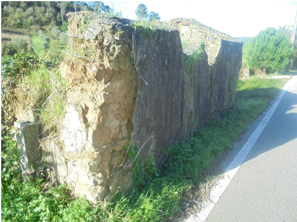
Foto 2 – Parede exterior do alçado confinante com a via pública
