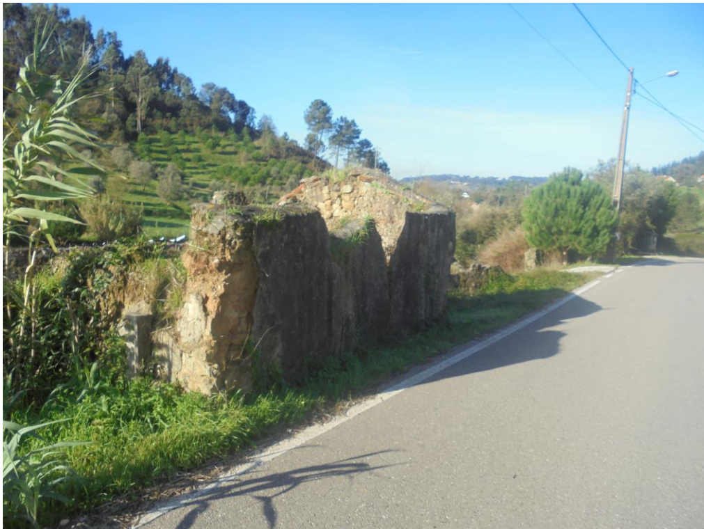
Foto 1 – Vista geral da edificação
