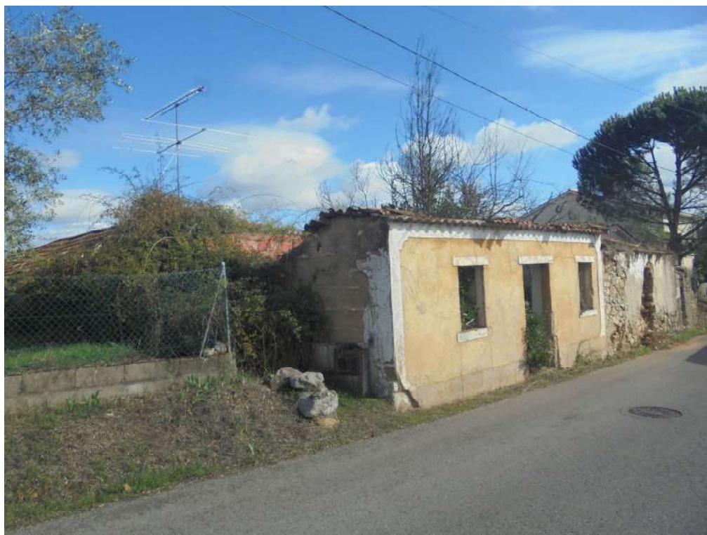
Foto 1 – Vista geral do edifício e do anexo
