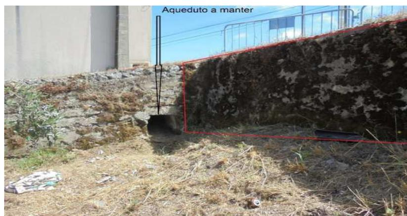
Figura 1 – Vista geral da boca de saída do aqueduto antigo a preservar. À direita, com contorno a vermelho, o muro existente a demolir e reconstruir.
