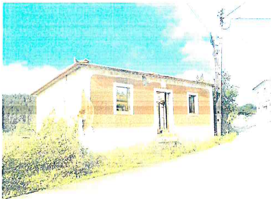
Foto 1 – Vista geral do edifício
