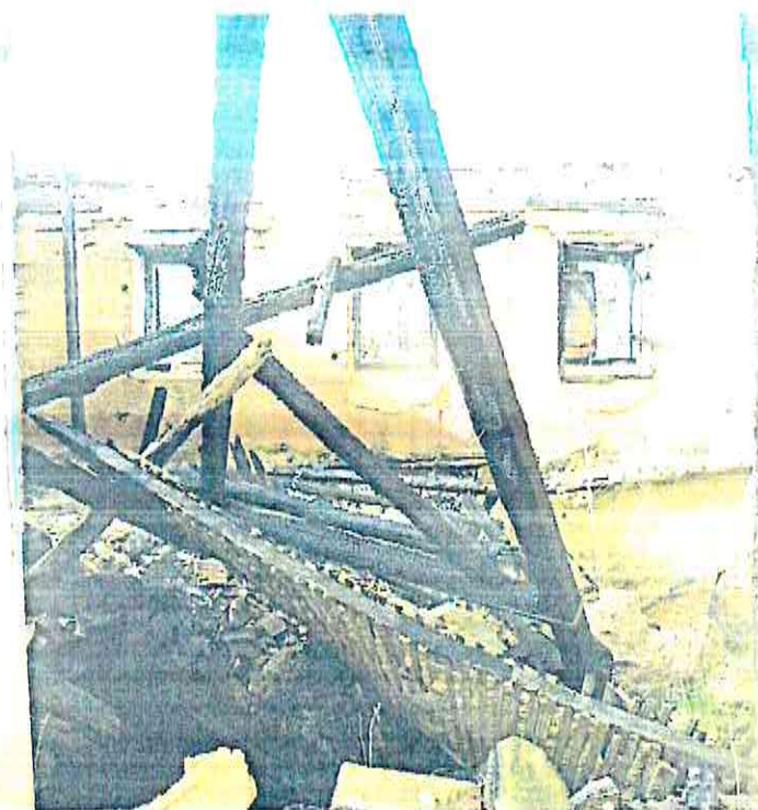
Foto 2 – Vista do interior do edifício
