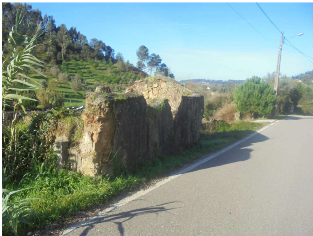
Foto 1 – Vista geral da edificação
