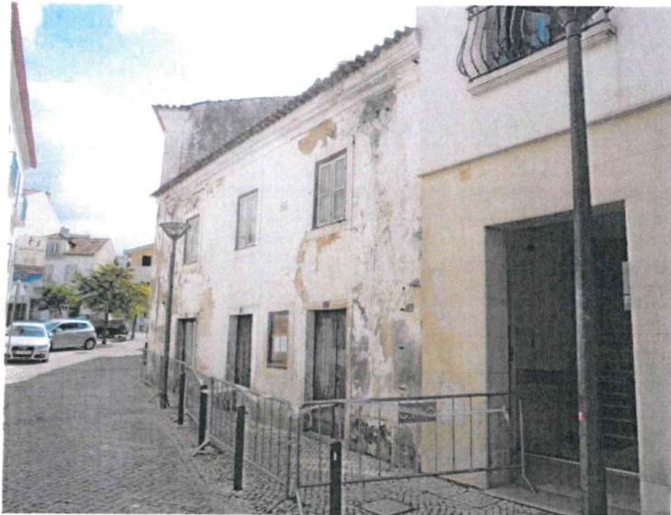
Foto 1 – Vista da fachada do edifício.
