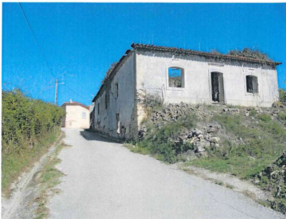
Foto 1 – Vista geral da edificação.
