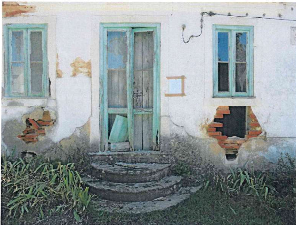
Foto 2 – Vista da fachada da edificação, confinante com a via pública.
