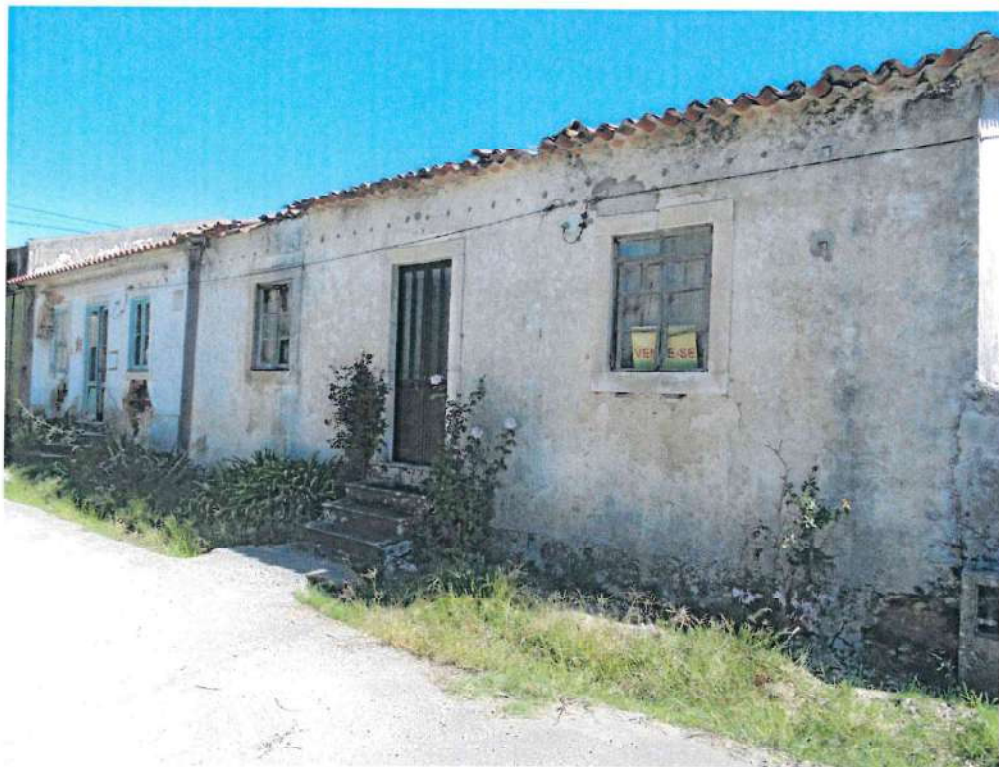
Foto 1 – Vista geral da edificação.
