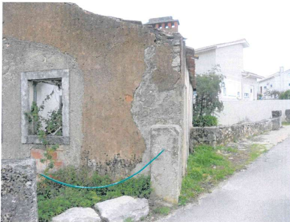
Foto 2 – Vista parcial da edificação, confinante com a via pública.
