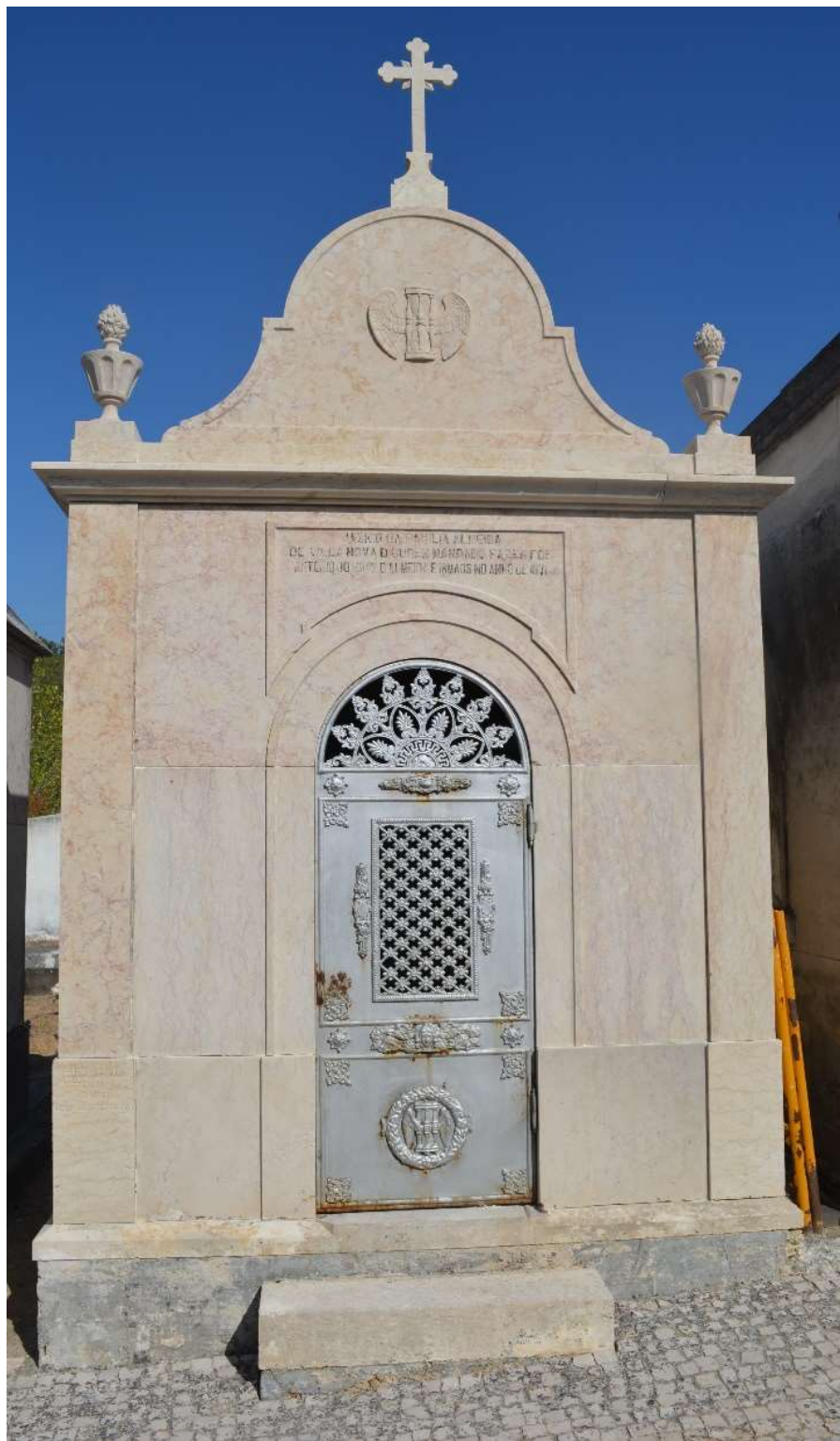
Jazigo da Família Almeida no decorrer da intervenção de conservação e restauro
