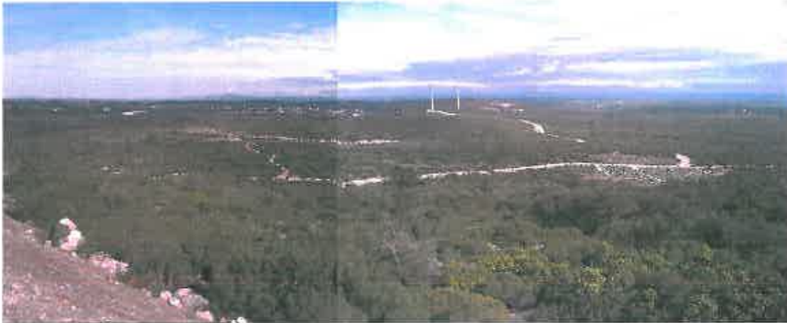
Fotografia 1 - Perspectiva panorâmica da área a intervir, obtida a partir do aerogerador nº 10 do Parque Eólico do Bairro (Pias Longas)
