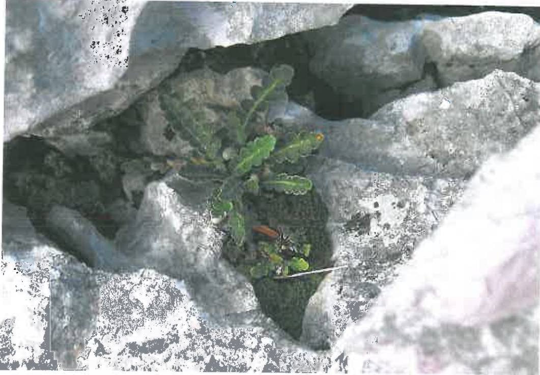
Figura 9 - Vegetação em fissuras de rocha calcária
