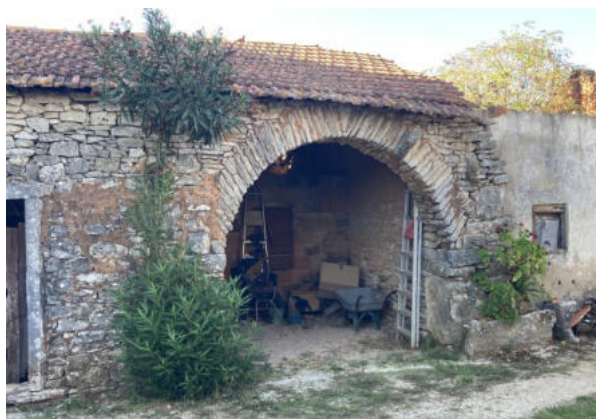
Construção vernacular em pedra não rebocada
