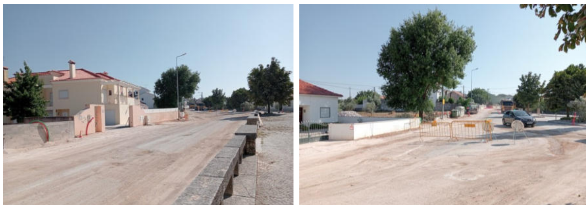
Figura 110. Obras de requalificação na Estrada Principal de Fátima (Fonte: levantamento de campo, 2025)
