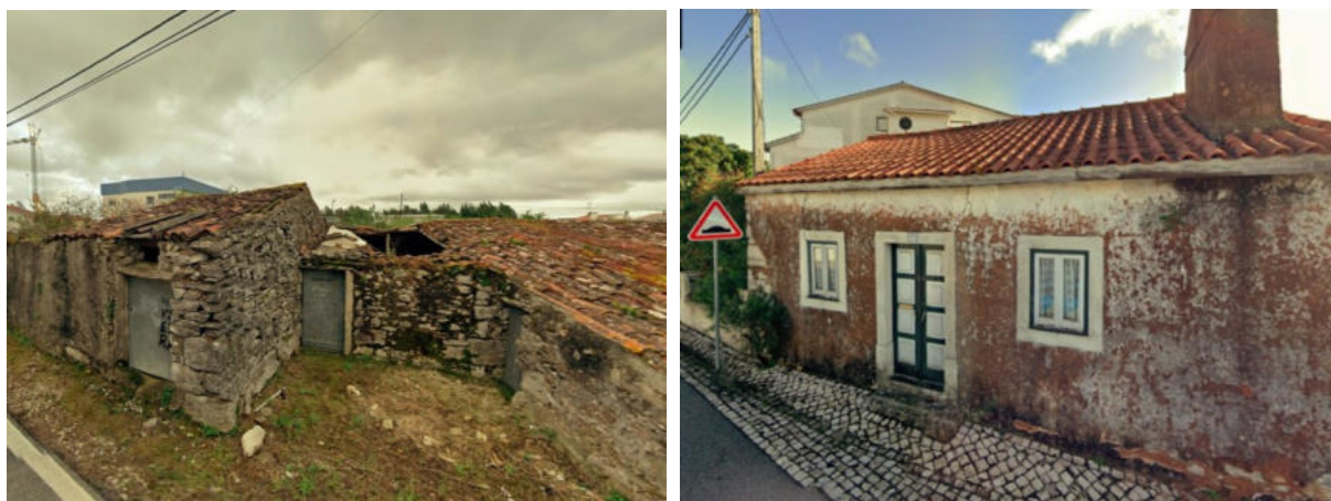
Figura 39. Aglomerado de Lomba d'Égua, construções tradicionais em estado avançado de degradação (Fonte: Google Maps®, 2024)
