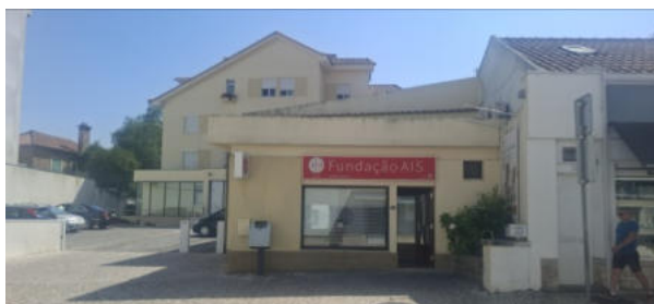
Fundação AIS (Rua Francisco Marto)
